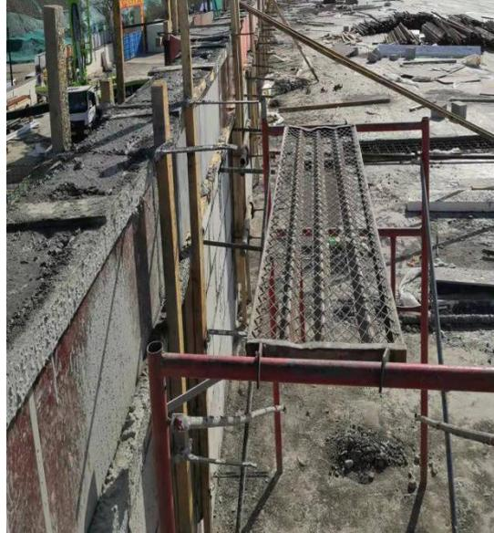
4、女儿墙边有泵管流出的剩余混凝土，事故发生后泵管移动至女儿墙内侧 1.5m 位置停止，泵管下垂软管口与女儿墙作业面平齐。
