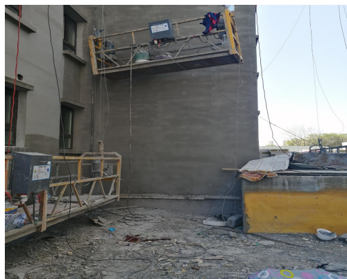
图 2：吊篮位置（7#吊篮是事故发生后下降的）
