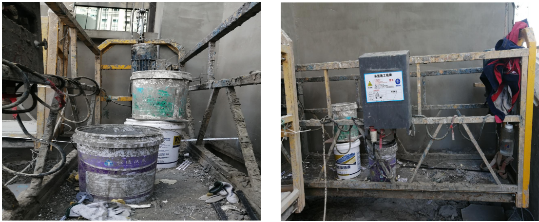
图 8：吊篮内物品放置
