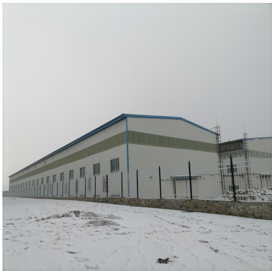
项目区北侧-天山集团铸造厂
