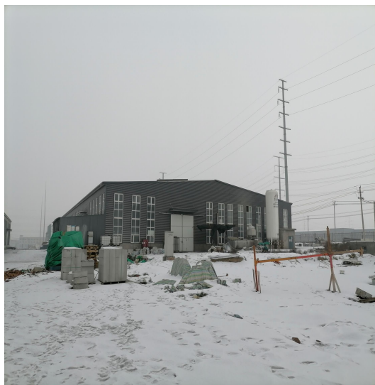
项目区南侧-新疆华泰兴发建材有限责任公司厂房
