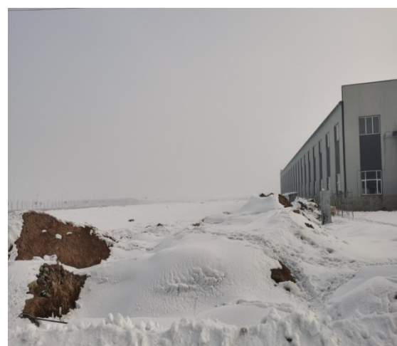
项目区北侧空地
