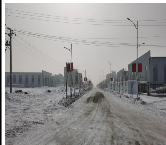
项目区西侧园区道路
